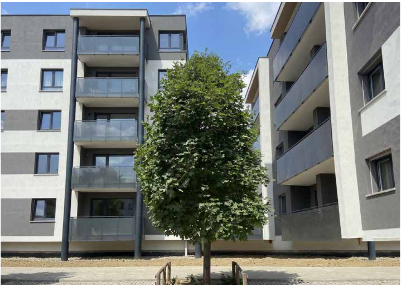
PARAPETTO PALADINA - via Greta Garbo (BO)
