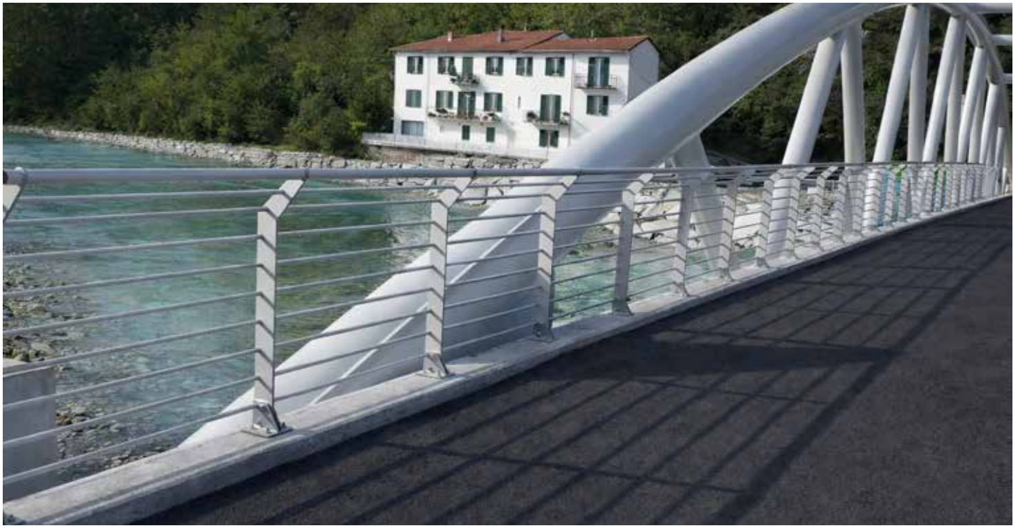
ORIZZONTE PASSERELLA SU PONTE
