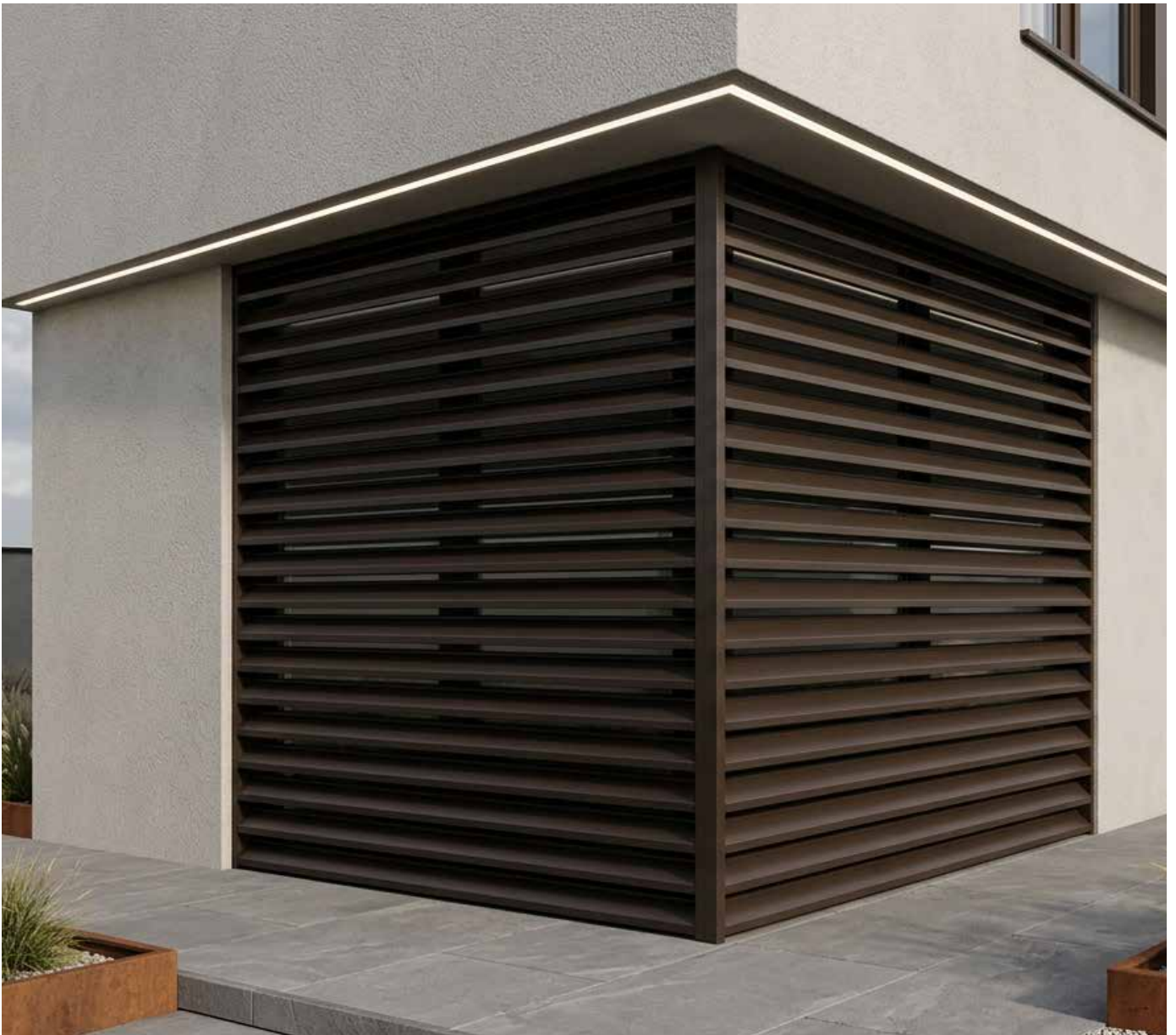
RIVESTIMENTO DI FACCIATA CON PROFILO "MONACA" ANODIZZATO DARK BROWN Via delle Suore (MO)
