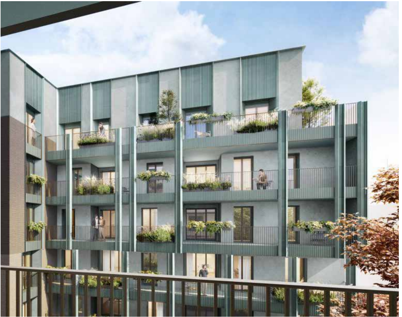
PARASTE VERTICALI DECORATIVE IN LAMIERA PRESSOPIEGATA SU PROGETTO DELL'ARCH. CINO ZUCCHI Via Pestalozzi (MI)
