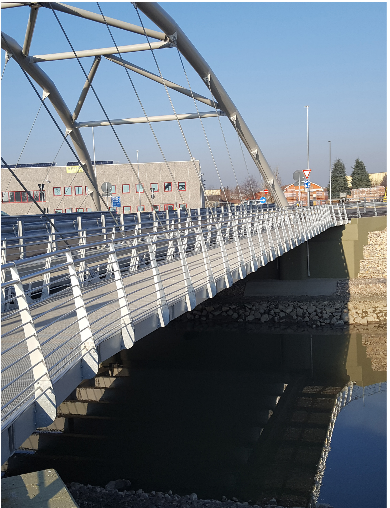
ORIZZONTE URBANO & ALUPLANA PONTE SUL CANALE DI BURANA - Borgo Scala, Bondeno (FE)
